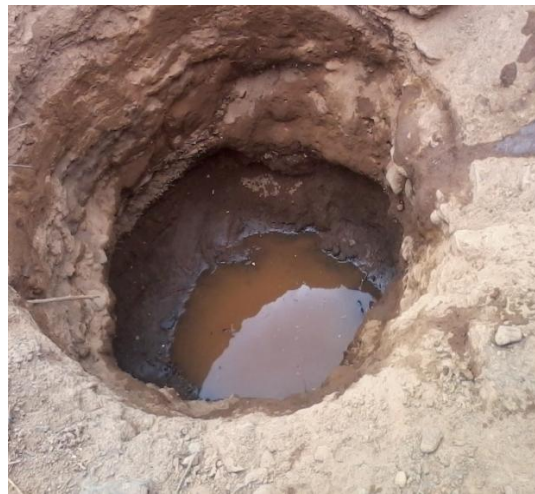
(d) Dug well in Ribkwo
